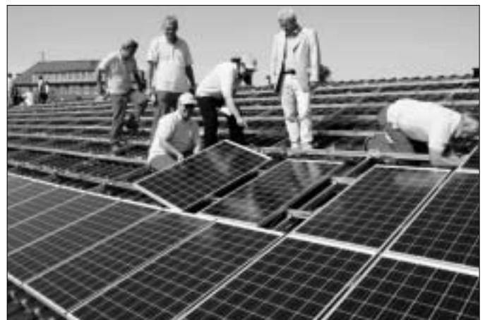
Installation der Solaranlage auf dem Grundschuldach: 2. v. r. OV Ecke, 5. v. r. Dipl.-Ing. Siebert, 6. v. r. Elektromeister Scharper, der für die Elektroinstallation verantwortlich zeichnete Fotoclub Reflex Christian Scholz
