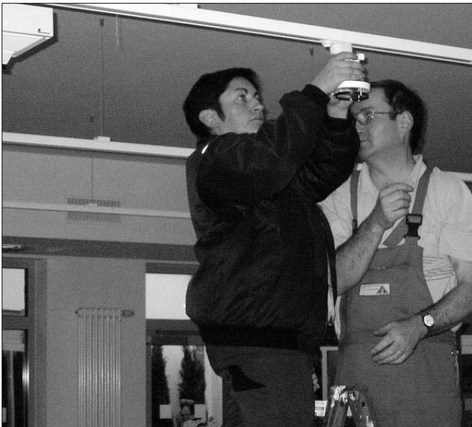
Herr Possiwan, Monteur der Firma Elektroanlagen Adelsberg GmbH, unterstützt von Frau Grafe, Hausmeisterin der Grundschule Weixdorf, bei den letzten Handgriffen an der neuen Beleuchtungsanlage.
