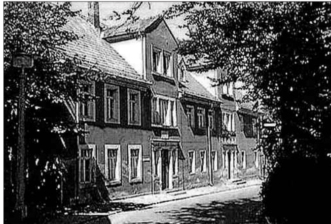
Das alte Schulgebäude in der Kirchgasse in Lausa Foto: Internetportal Weixdorf
