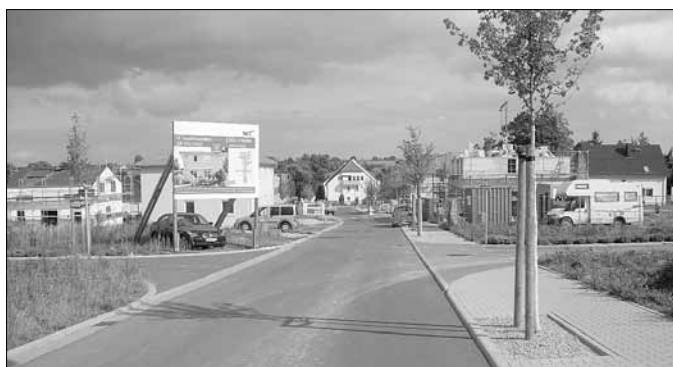
Auf dem Stieglitzweg besteht an den Einfahrten zum Kleiber- sowie Gimpelweg ein abgesenkter Bordstein, darüber hinaus teil-
